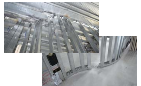
従来はTSで追っていたカーブ上の墨出しも器械の誘導に従うだけ ▲
