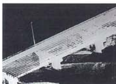
約200Mの橋梁を計測
