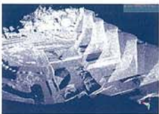
ダム全体を、7箇所からスキニングし合成
