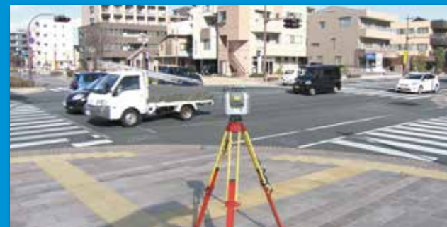
多くの車が行きかう交差点で点群計測
